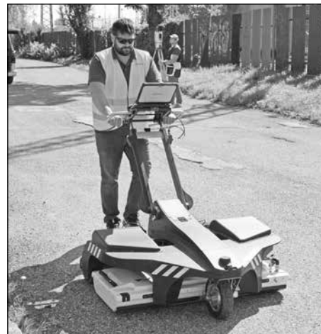
Kontrolou prešiel jeden z mostov na Fabiniho ulici. Málokto si uvedomuje, že nadjazd tvoria 4 mosty, teda nielen ten železničný.
